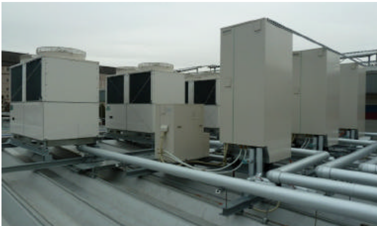
二酸化炭素冷媒冷凍機+過冷却給湯ユニット
