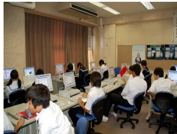
コンピュータールームのエアコン
