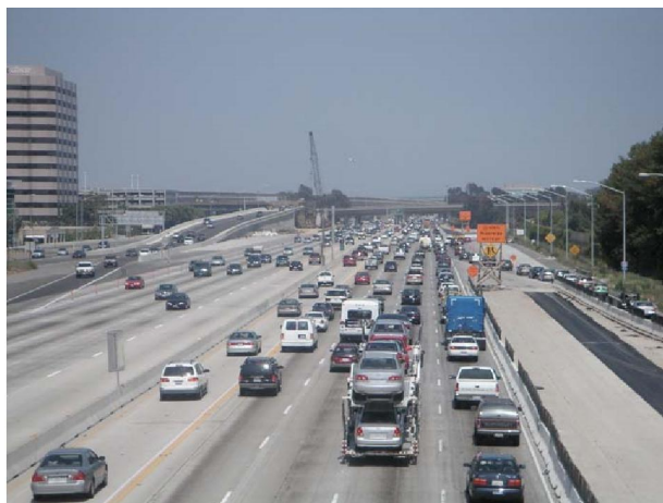
片道、5 車線にランプから車線が追加されて 6 車線
