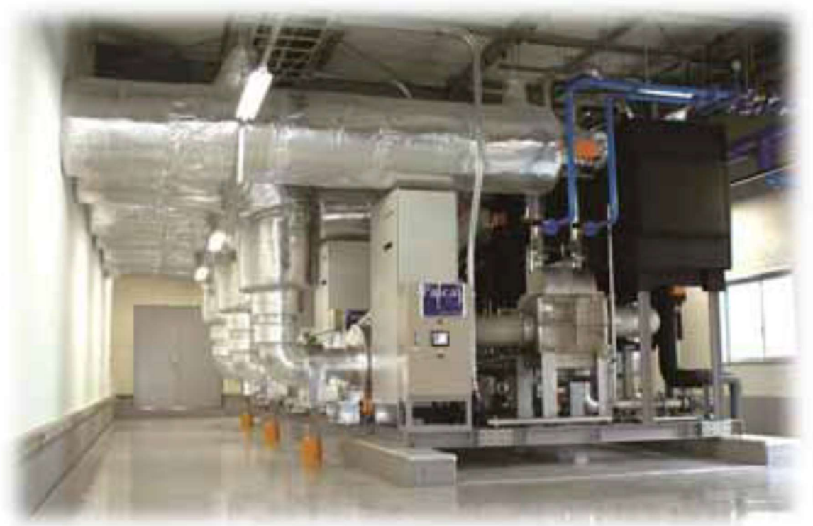
図-1 超低温冷凍倉庫に導入された空気冷凍システムの例
