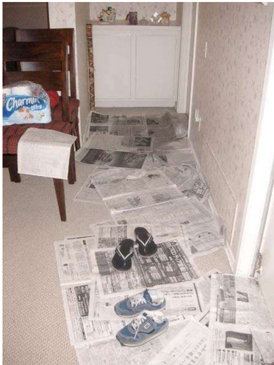
トイレからの逆流で1階が水浸し
