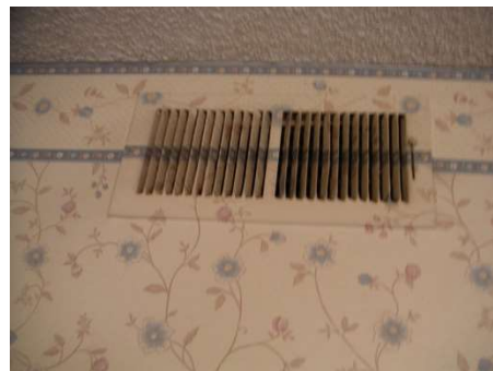
上：空調コントローラー：暖房はガス、冷房は室外機を動作、レバーで冷暖を切り替える 下：全室同時にダクトで冷暖房
