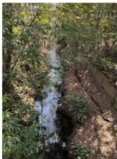
万助橋からの玉川上水
