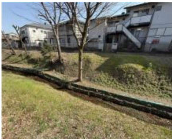
笹塚駅手前の開渠部分
