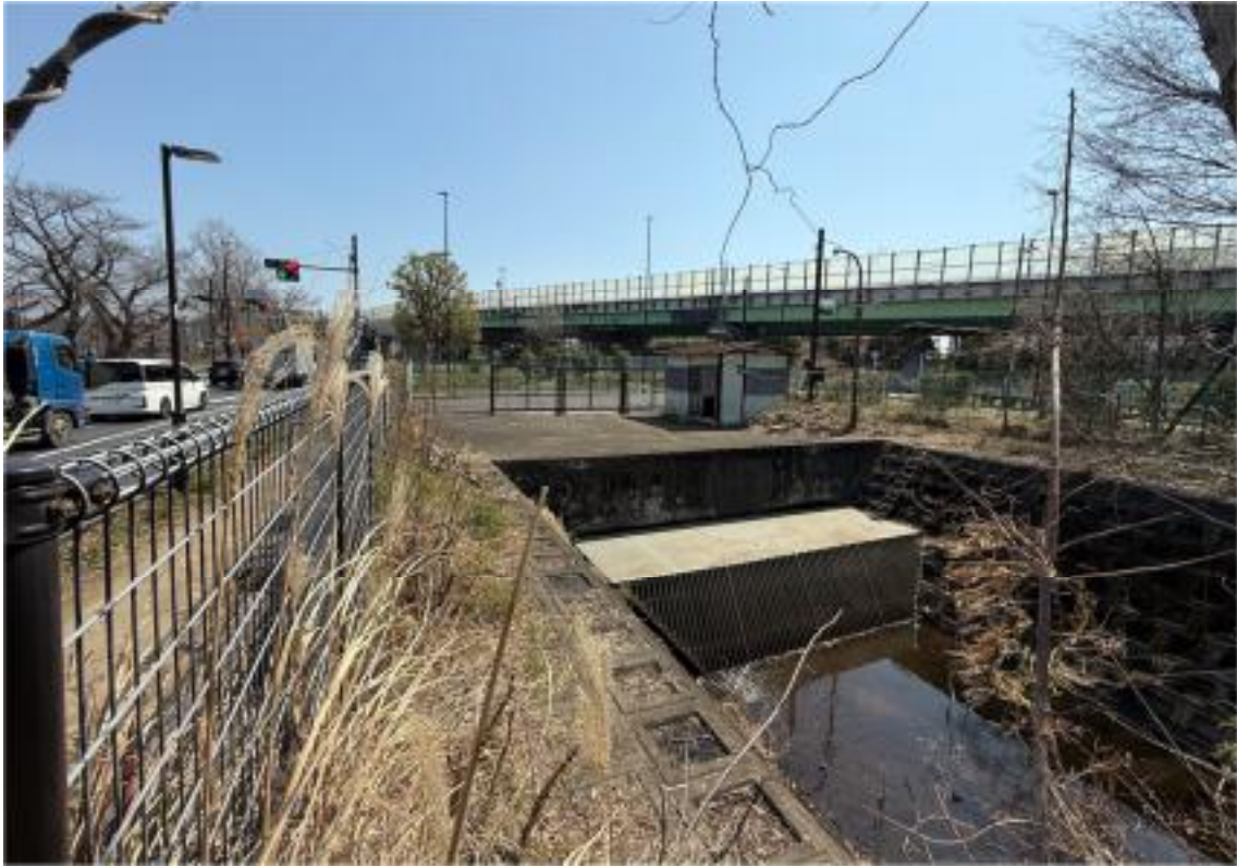
玉川上水はここで暗渠、左が東八道路、正面高架は中央高速
