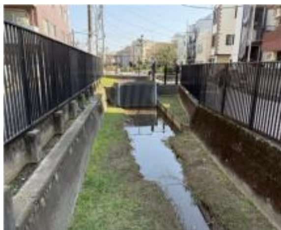
渋谷区の区境で暗渠となる（三田用水取水口
