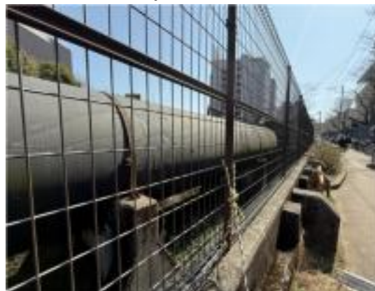
鋼管の水道橋
