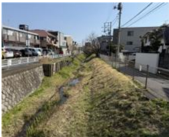
笹塚駅先の開渠部分
