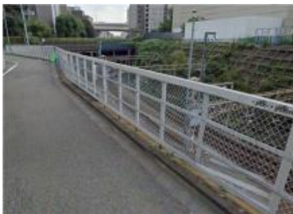
手前は開削された土地を通る井の頭線と交差する玉川上水水道橋
