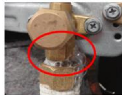
点検による漏れの確認
