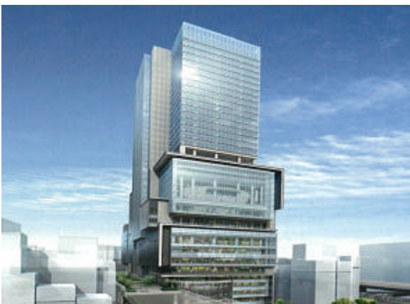
店舗全景（渋谷ヒカリエ）（ShinQs・地下3階-5階）
